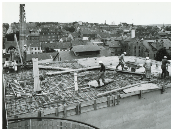
Ny maltsilo under opførelse sommeren 1962 på Horsens ny Malteri. Bygningsarbejderne har bundet jern og kører beton med trillebør til støbning.
