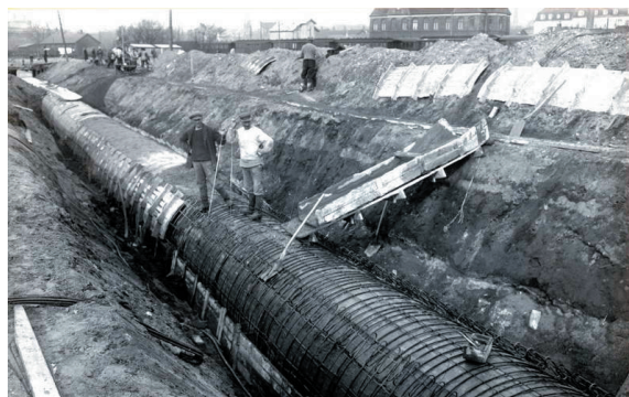
I 1928 fik Horsens Andels Svineslagteri ny kloakledning til Bygholm å. Her ses den under nedlægning på Andreas Steenbergs Plads.
