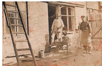
En gammel ejendom har fået ny dør og vindue ca. 1930. Murer Rasmus Petersen i døren med vaterpas og mortelbør klar til opmuring.
