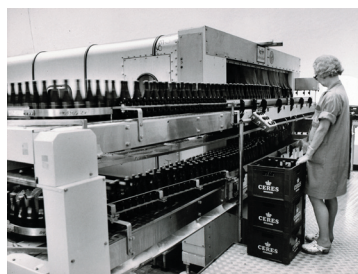
Horsens Bryghus tog i 1928 dette gennemautomatiserede tapperi i brug. Hver time blev der aftappet, etiketteret og pakket 6.000 flasker øl svarende til 120 kasser.
