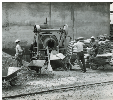
Ny maltsilo under opførelse sommeren 1962 på Horsens ny Malteri. Bygningsarbejderne har bundet jern og kører beton med trillebør til støbning.
