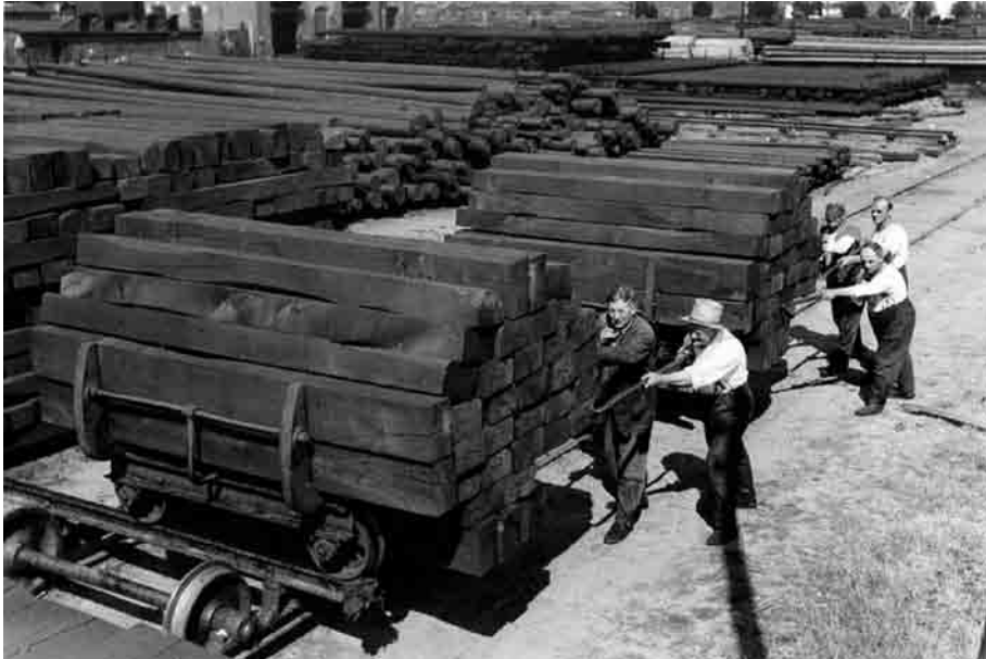
Bærevognen skubbes med de klargjorte sveller i kæpvognen.
